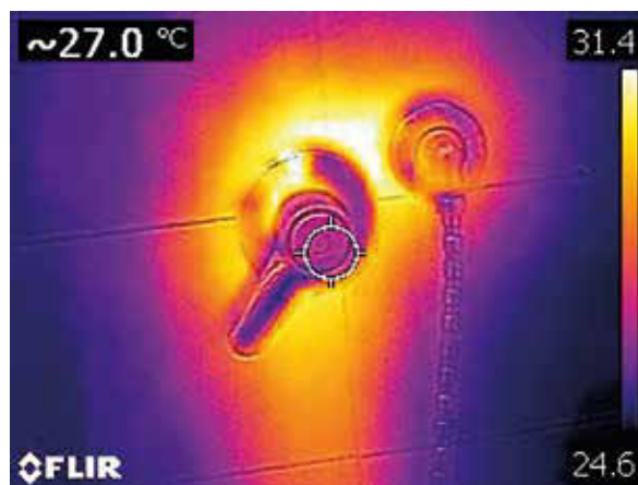
Dettaglio termografico che individua il percorso del tubo dell'acqua calda per la sostituzione di un miscelatore per doccia (foto L. Ghoniem)
